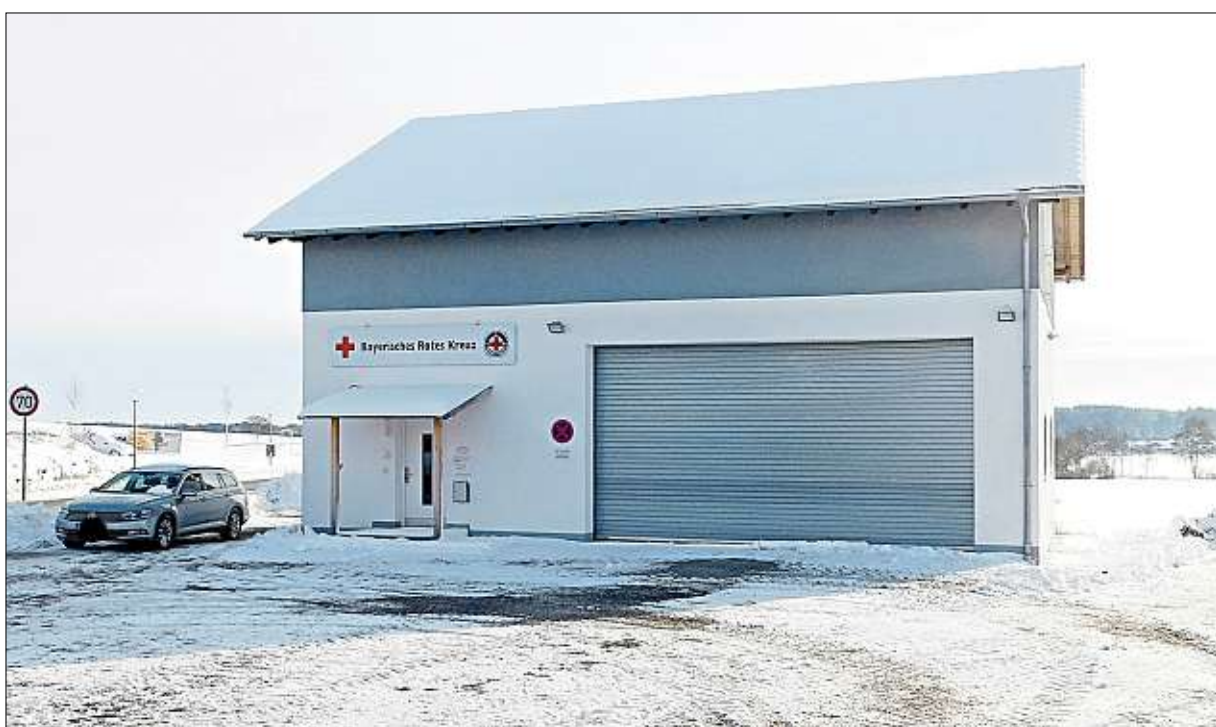
Am Schnaitsee BRK-Haus an der Kraiburger Straße wird ab Februar jeden Donnerstag der Corona-Impfbus des Landratsamts stehen. Zur Zeit wird alles für die Impfkation vorbereitet. – Foto: Unterforsthuber
